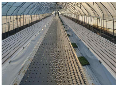
잇들개 양액재배 베드 설치
