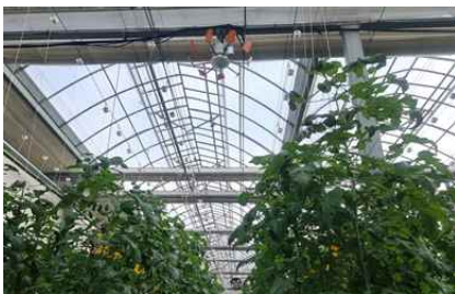
순환팬 설치 전체 모습
