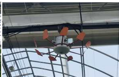
순환팬 설치 모습
