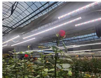
막대형(Bar type) LED 1, 2, 3줄 설치
