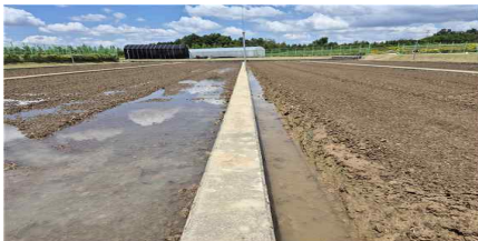
<비온 후 1일차, 우측 배수로 정비>
