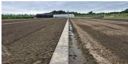
<비온 후 5일차, 우측 배수로 정비>
