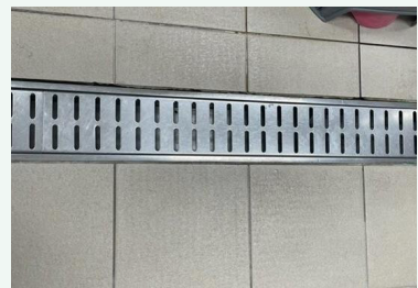
트렌치 설치 및 바닥 청결관리
