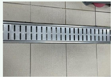
트렌치 설치 및 바닥 청결관리
