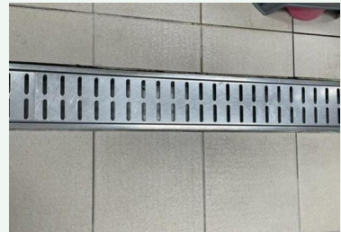
트렌치 설치 및 바닥 청결관리
