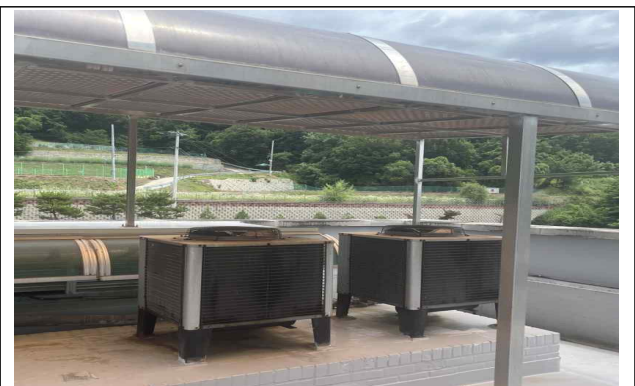
직사광선 차단막 설치
