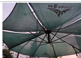
폭염 (그늘막 파손)
