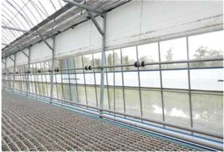
방충망 설치 및 관리 우수
